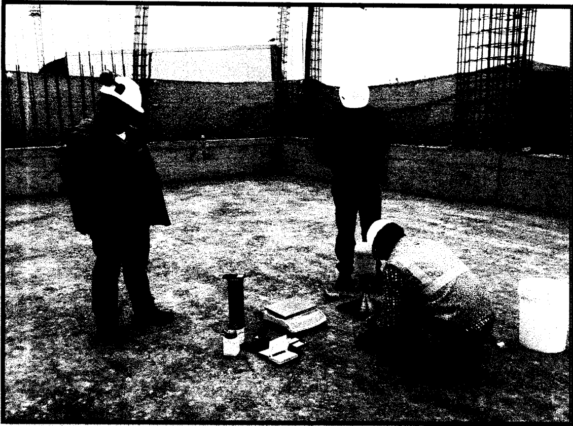
FOTOGRAFIA 19: Relleno de afirmado para compactación en área de fríos – prueba de densidad de campo.
