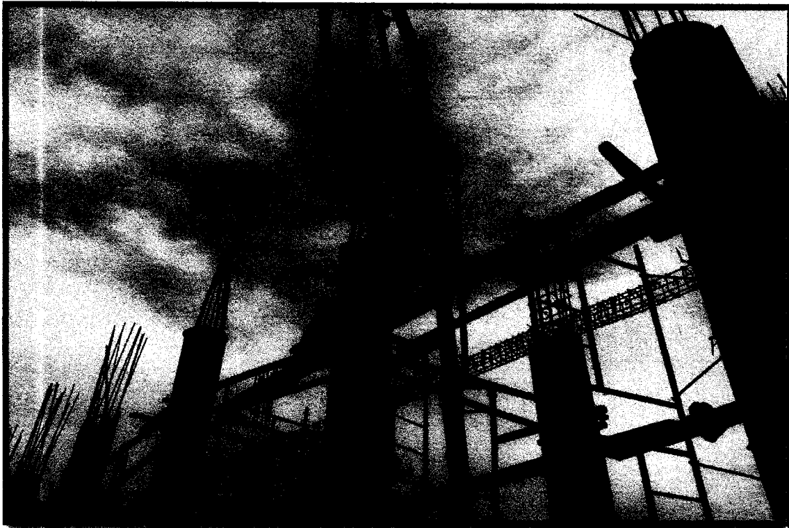
FOTOGRAFIA 17: Concreto en columnas circulares.
