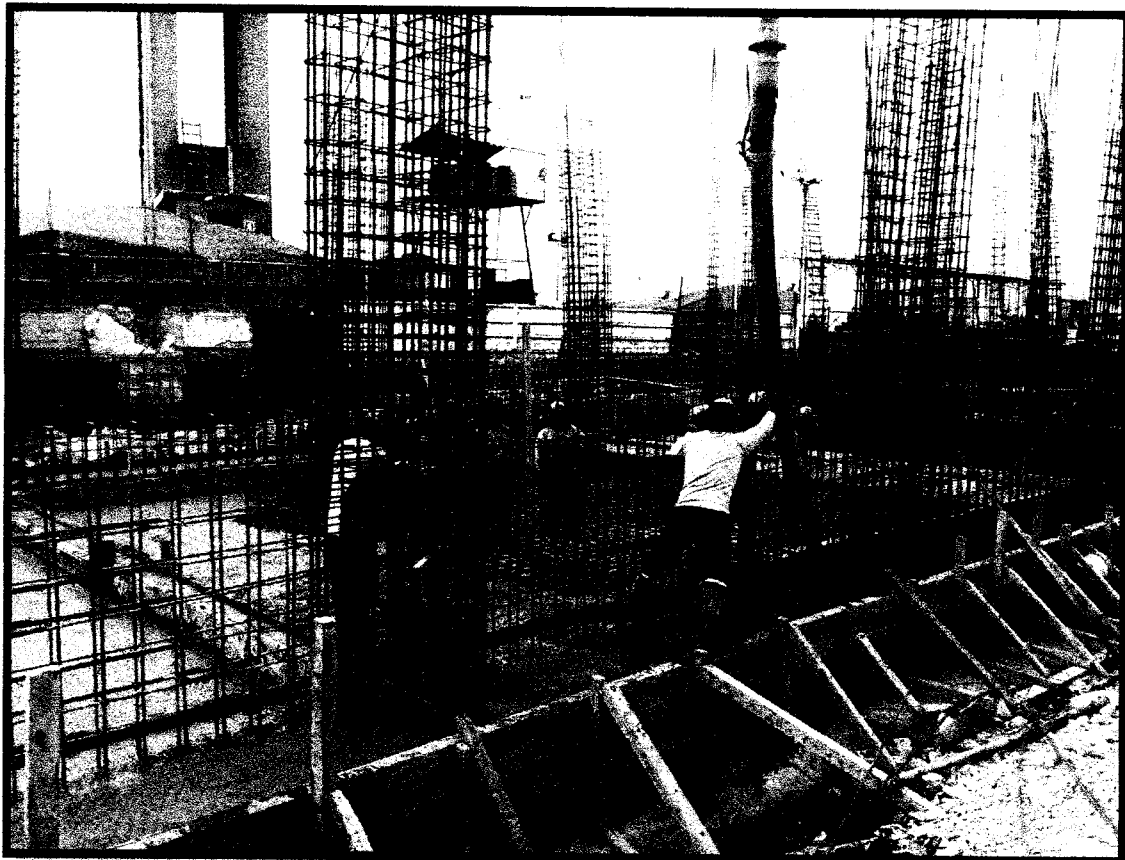
FOTOGRAFIA 12: Concreto en platea de cimentación y viga de cimentación.
